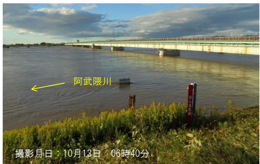
阿武隈川下流 阿武隈橋(8.1k付近) 宮城県岩沼市阿武隈地先
