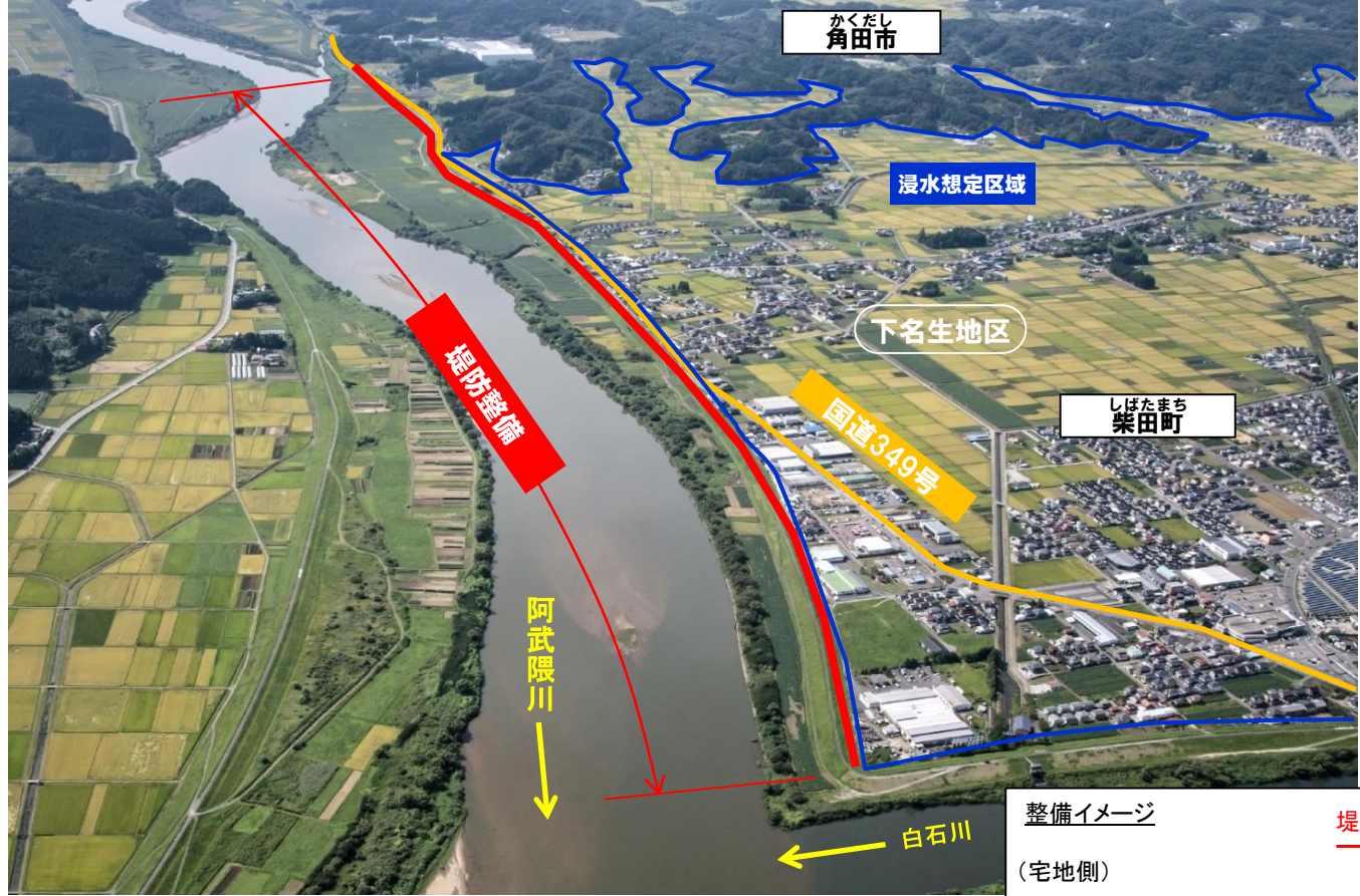
【柴田町 下名生地区 堤防整備】
