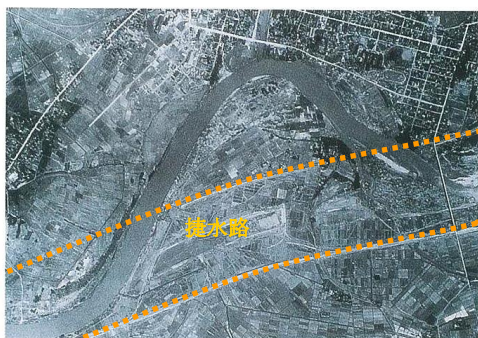
大曲捷水路改修工事中（昭和36年）
