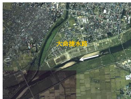
大曲捷水路完成後（平成22年）
