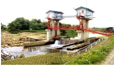
大久保頭首工（改築前）
