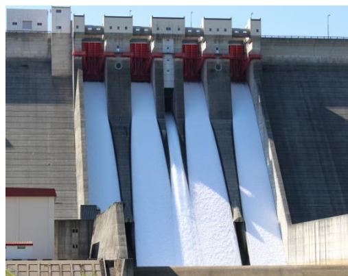
玉川ダムの試験放流の様子
