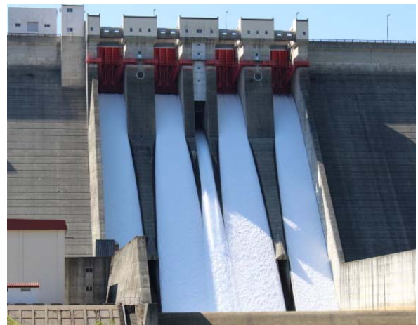
玉川ダムの試験放流の様子
