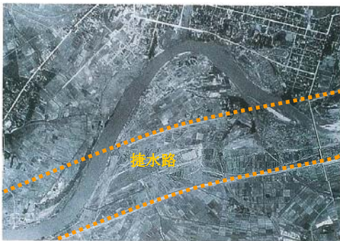
大曲捷水路改修工事中（昭和36年）
