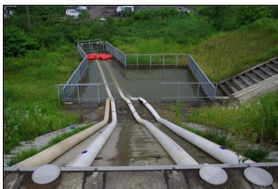
排水ポンプ車による排水作業（大仙市）
