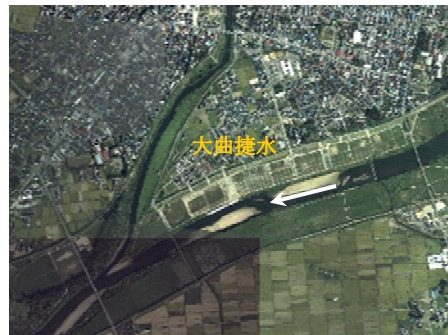
大曲捷水路完成後（平成22年）
