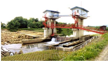
大久保頭首工（改築前）
