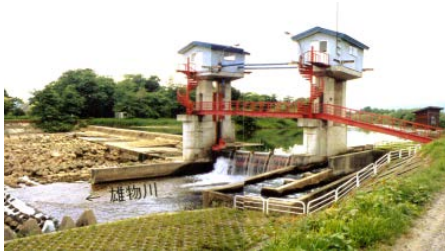
大久保頭首工（改築前）
