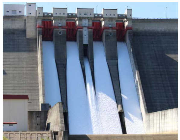
玉川ダムの試験放流の様子
