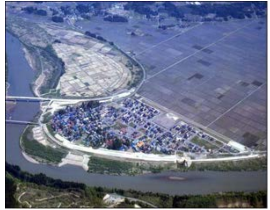
強首輪中堤（完成後）
