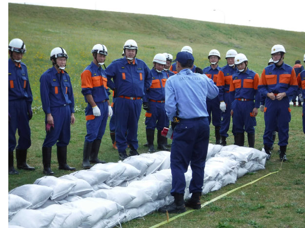
積み土のう工法
