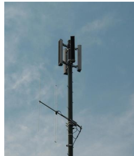
防災行政無線施設整備
