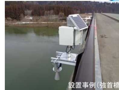
設置事例(強首橋)
