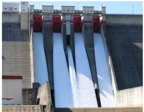
玉川ダムの試験放流の様子
