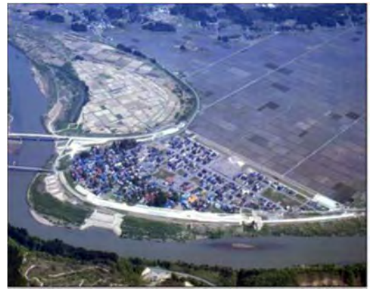
強首輪中堤（完成後）
