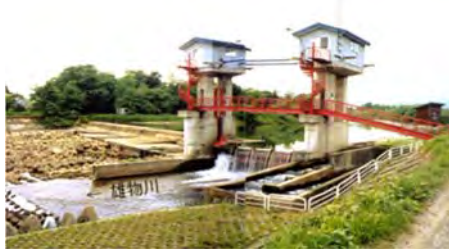
大久保頭首工（改築前）
