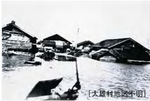
S22.7洪水時の被害状況（横手市：旧大雄村）
