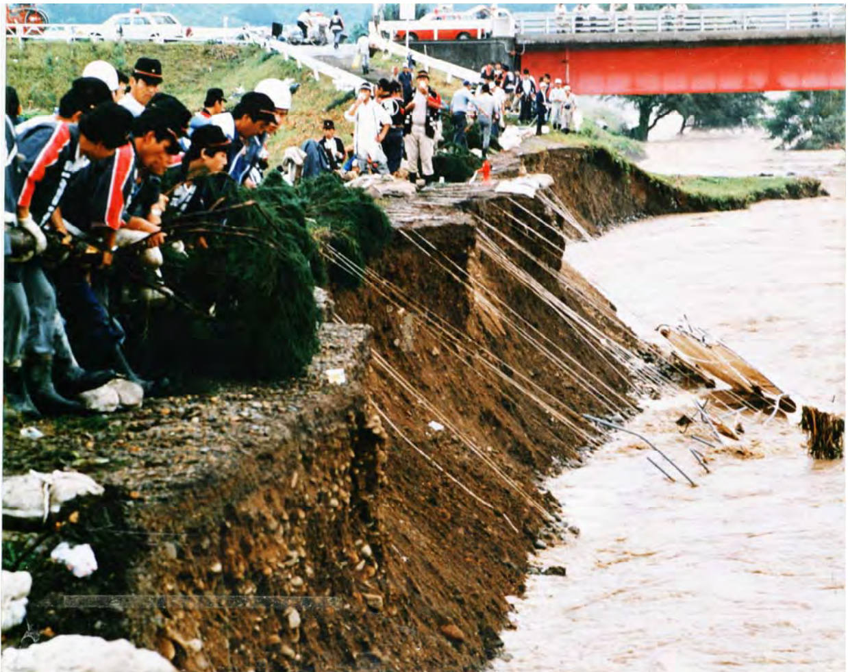
昭和62年8月洪水 成瀬川左岸における水防活動
