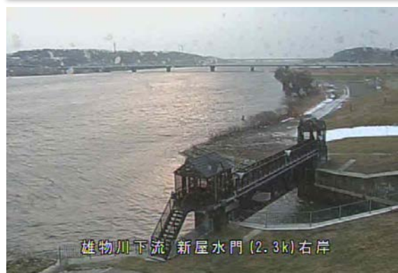
映像配信の例 (雄物川2.3k右岸 新屋水門)
