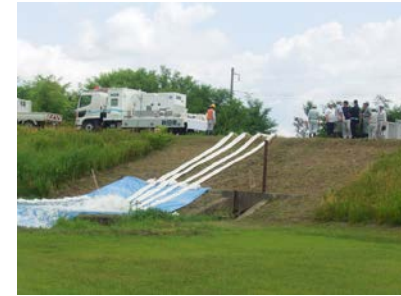
参考-3 排水ポンプ車の操作訓練
