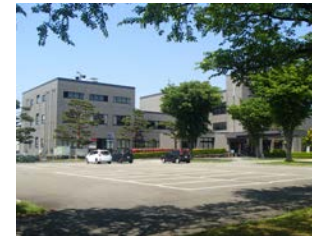
参考-2 役場庁舎駐車場
