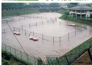
防災調整池を平時はテニスコートとして利用（横浜市）
