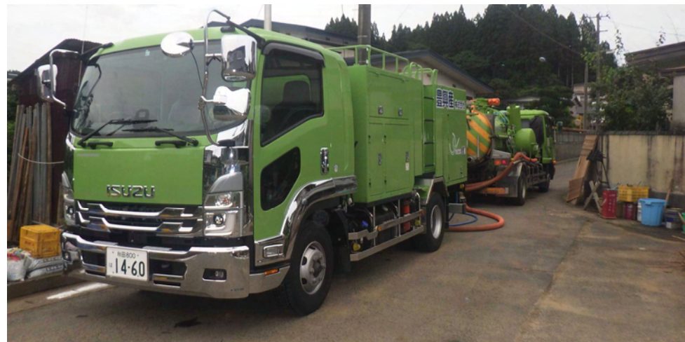
合併浄化槽の清掃作業
