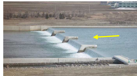
大久保堰（改築後）
