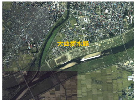
大曲捷水路完成後（平成22年）
