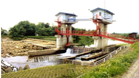
大久保頭首工（改築前）
