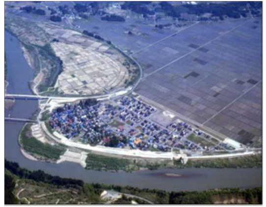
強首輪中堤（完成後）
