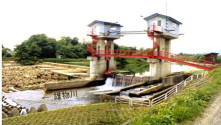
大久保頭首工（改築前）
