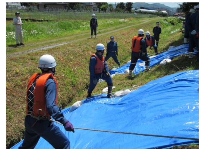
水防講習会(応急シート張り工法)
