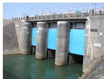
新屋水門（改築前）
