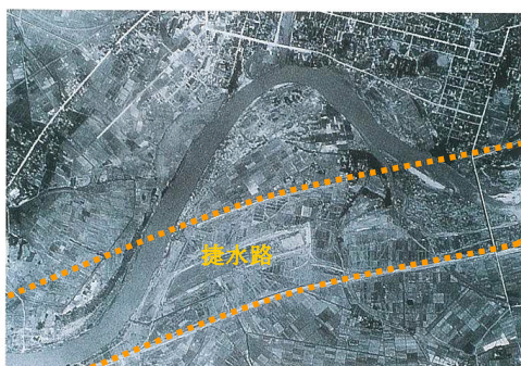
大曲捷水路改修工事中（昭和36年）
