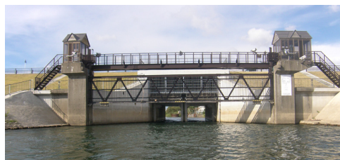
新屋水門（改築後）
