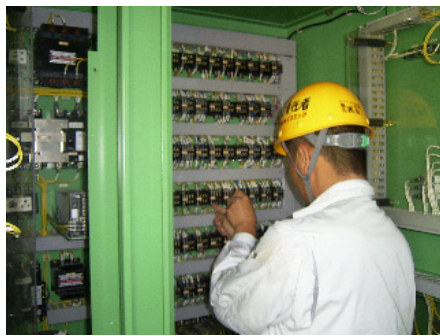
機側操作盤の点検状況
