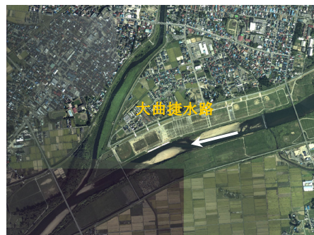
大曲捷水路完成後（平成22年）
