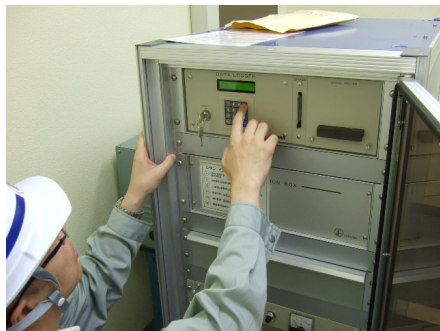
観測施設の点検状況
