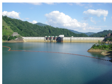
玉川ダム 流木止施設
