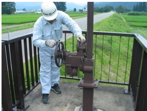
施設点検（樋門ゲート設備）の状況
