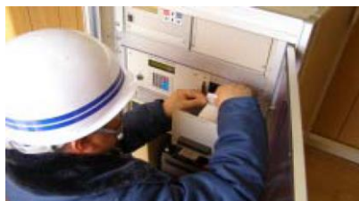
観測所保守点検状況
