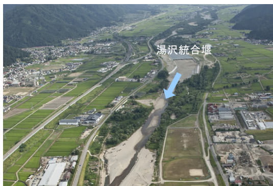
雄物川上流部の砂州の状況
