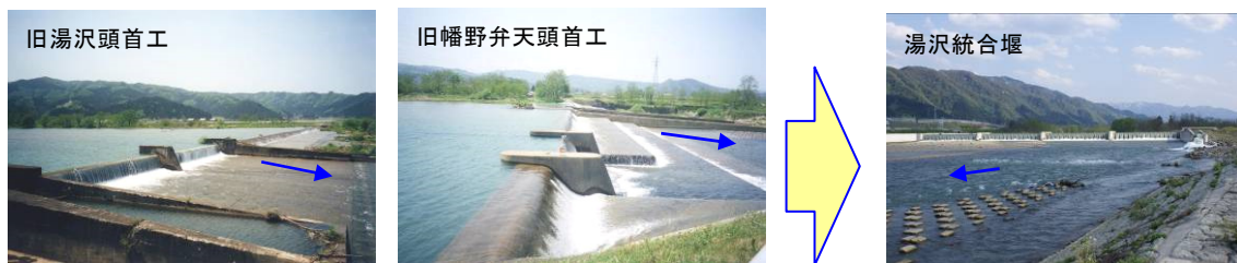
湯沢頭首工改修前後の施設状況
