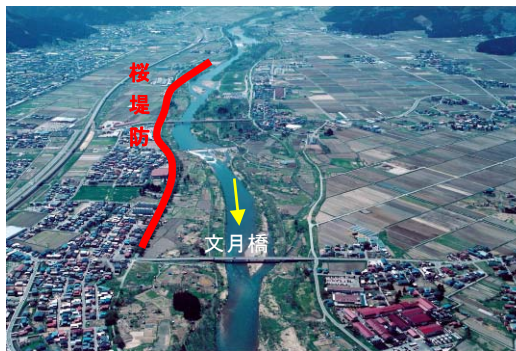
文月橋上流の桜堤防区間
