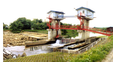
大久保頭首工（改築前）
