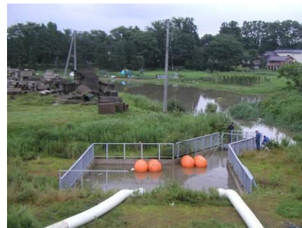
角間川排水ピット
