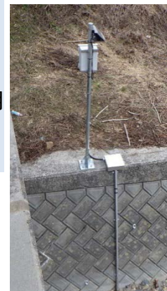
設置状況(石貝川)
