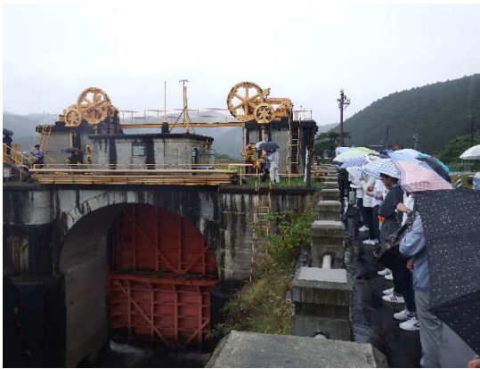
▲脇谷閘門・洗堰を見学
