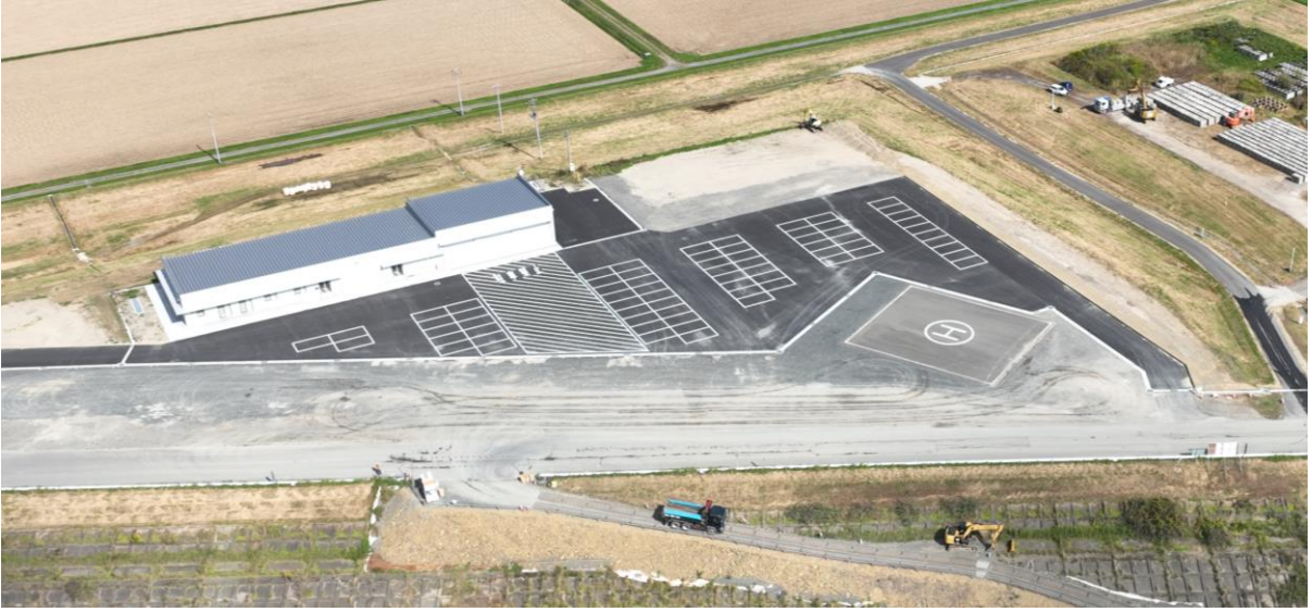
▲吉田川志田谷地防災センター 完成
