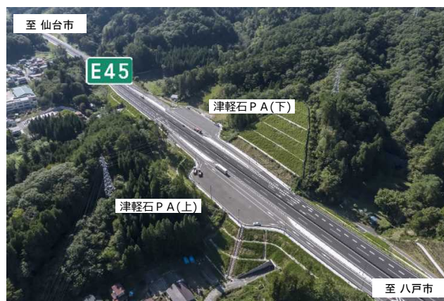
▲供用中の三陸沿岸道路 津軽石PA（宮古市）
