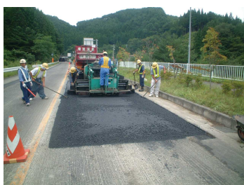
▲舗装修繕の様子
