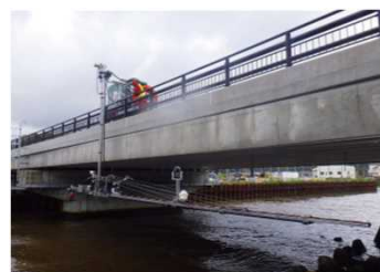
点検支援技術による橋梁点検
