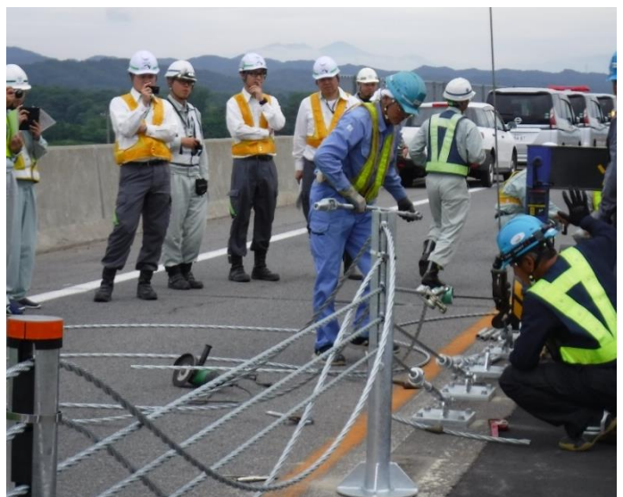
▲ワイヤロープ緊張作業の見学状況▲
