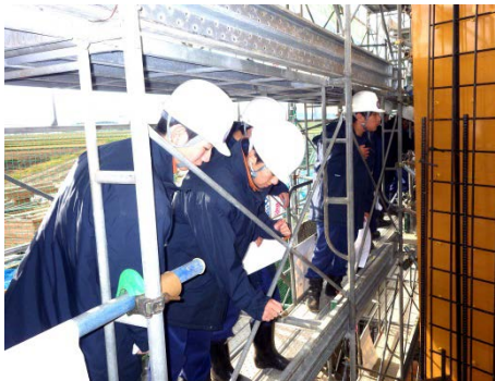
▲足場に昇り、現場見学を行う様子▲
