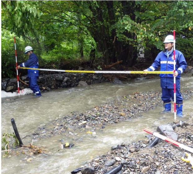
▲被災状況調査の様子▲
