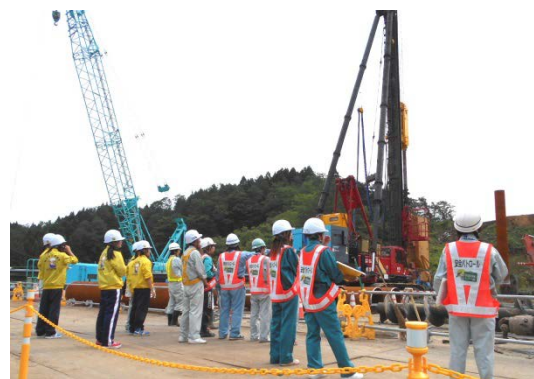
▲上野西地区橋梁下部工工事の点検の様子▲
