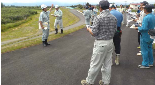
▲写真：地域住民も参加しての点検の様子▲
