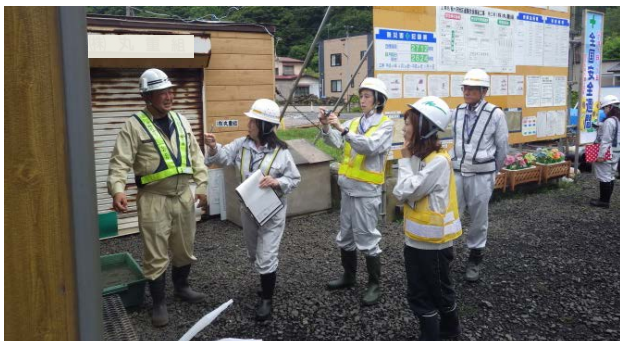
▲作業環境点検の様子▲
