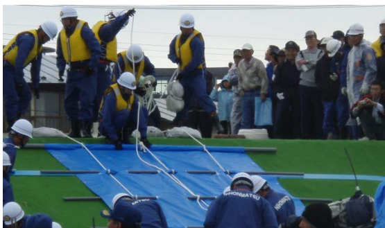
シート張工法訓練の様子
