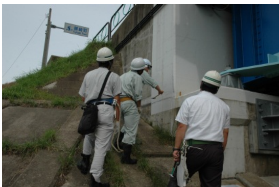
▲点検ハンマーを使用した打音検査
