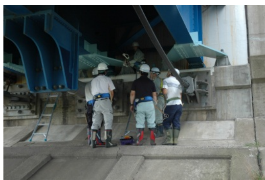
▲近接目視点検により損傷状況を確認
