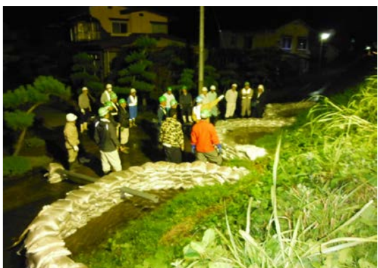
昨年の洪水の際、「漏水」箇所の拡大を防止するため実施した「月の輪工」
