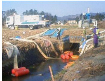
山元町花笠排水機場での作業状況
