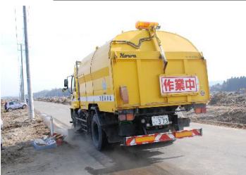
宮城県山元町での作業状況
