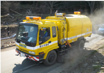
岩手県山田町船越大浦での作業状況
