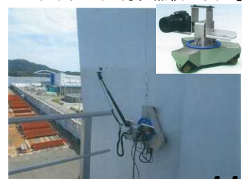
主塔外面(上部側面)
