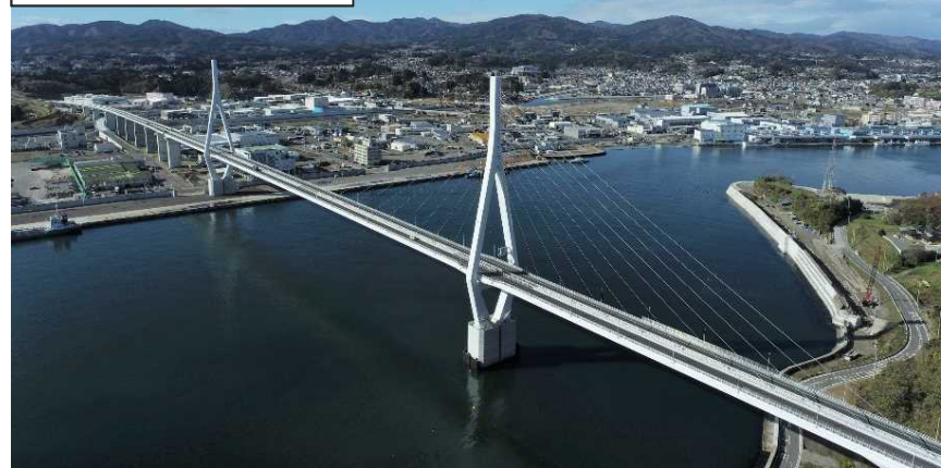
R4.11.17 点検実施内容公開の様子
