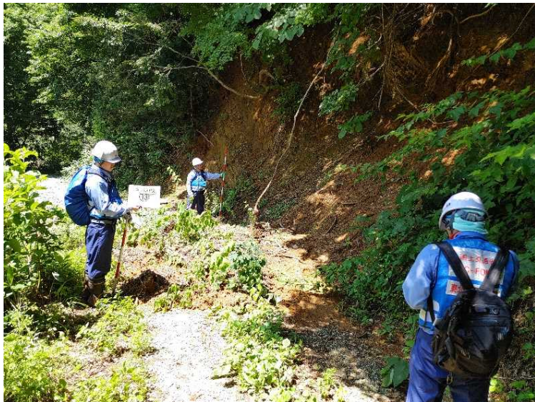
被災概要調査（馬場目地内）
