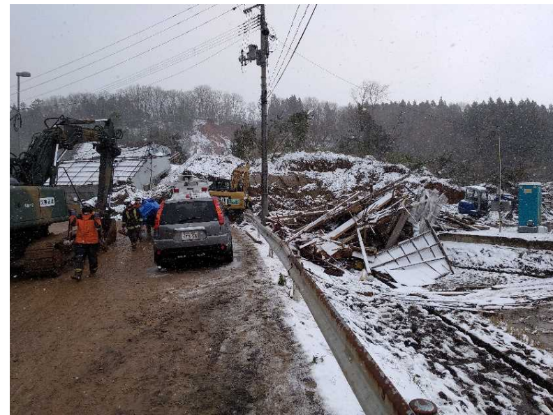
被災現場状況
