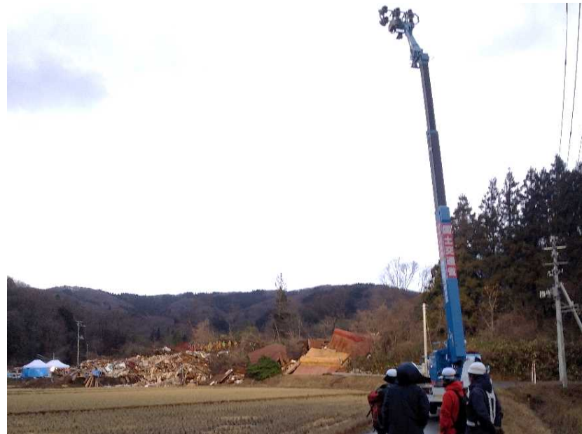
照明車設置状況
