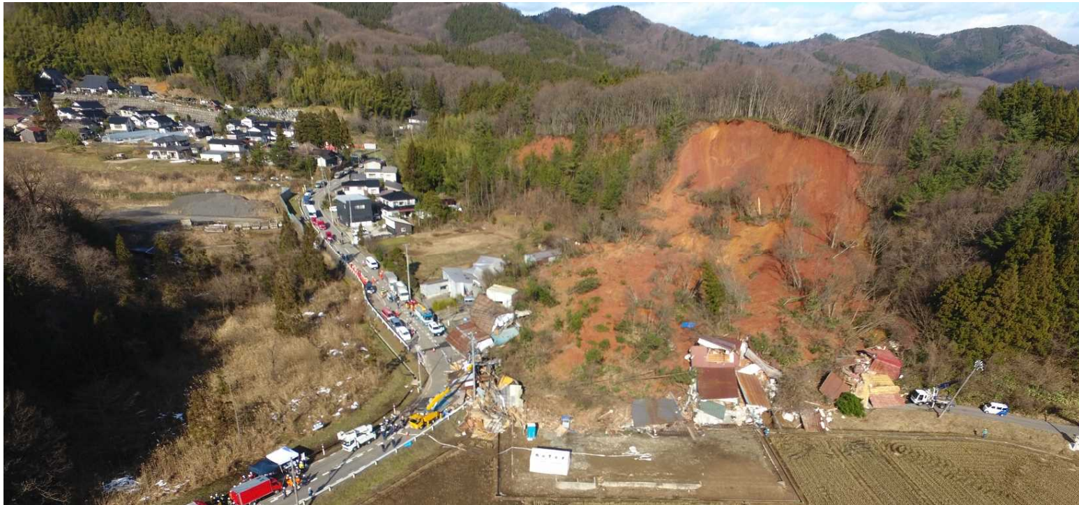
UAVによる被災状況確認
