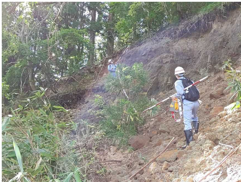
被災状況調査（岩崎地内）
