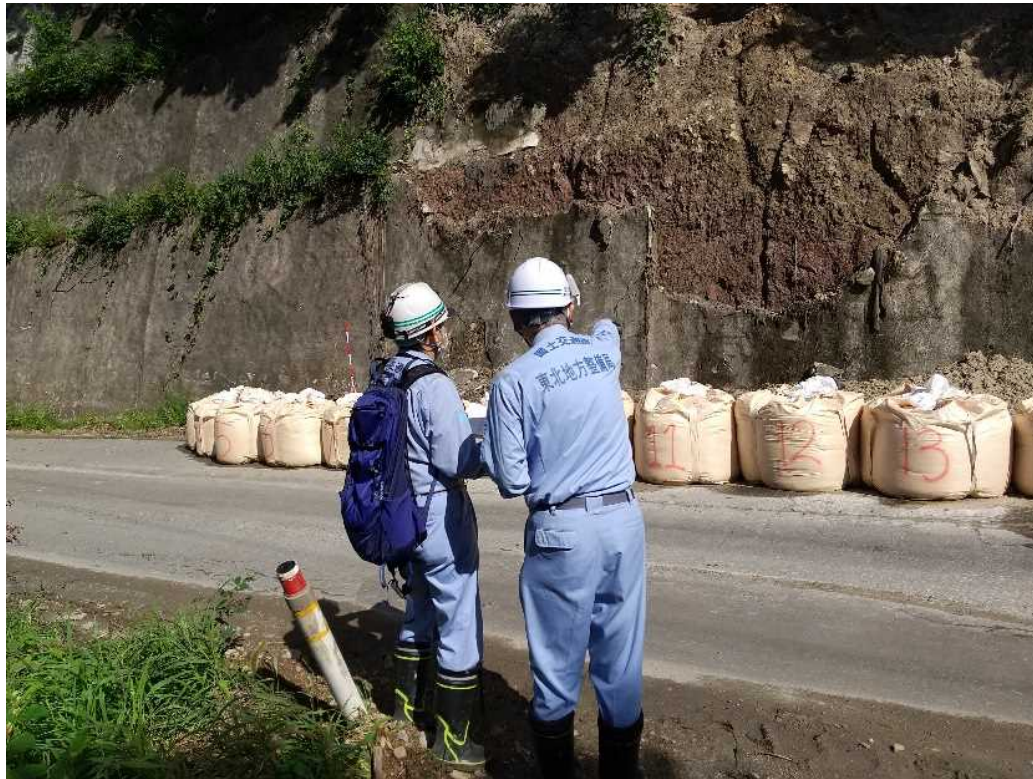
被災状況調査（追良瀬地内）
