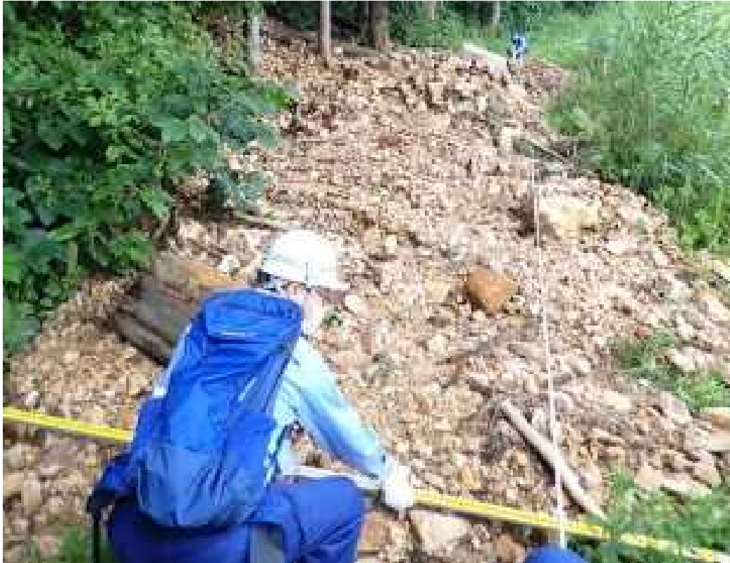
被災状況調査（鬼袋沢川）
