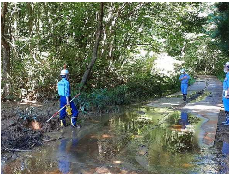
被災状況調査状況（袴腰山地内）
