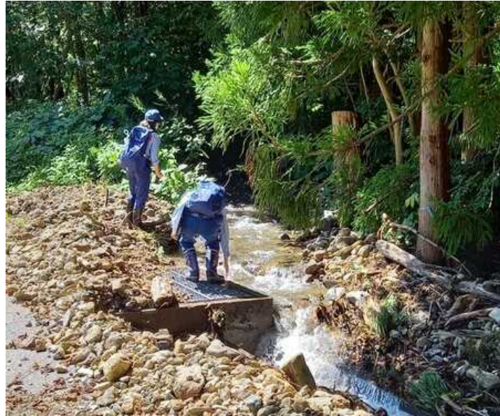
被災状況確認（一ツ森町地内）
