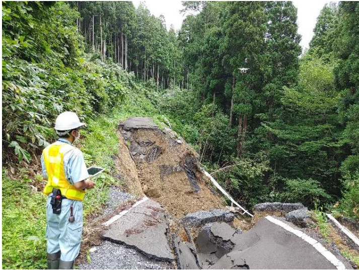
UAV被災状況確認（袴腰山地内）
