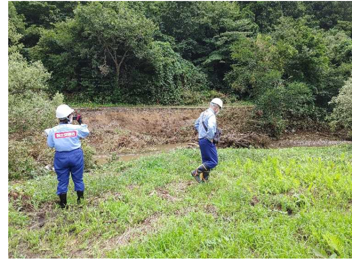
被災状況確認（袴腰山地内）
