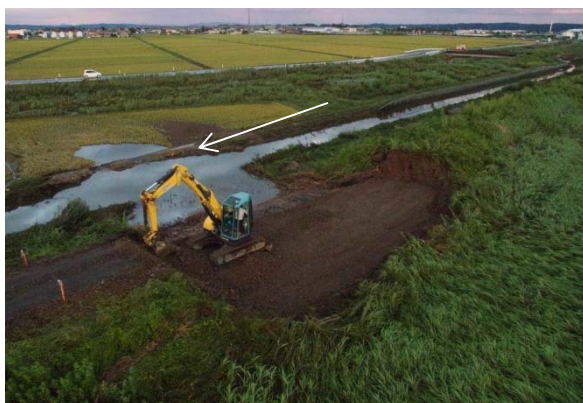
中流工区復旧状況(13日17:00)
