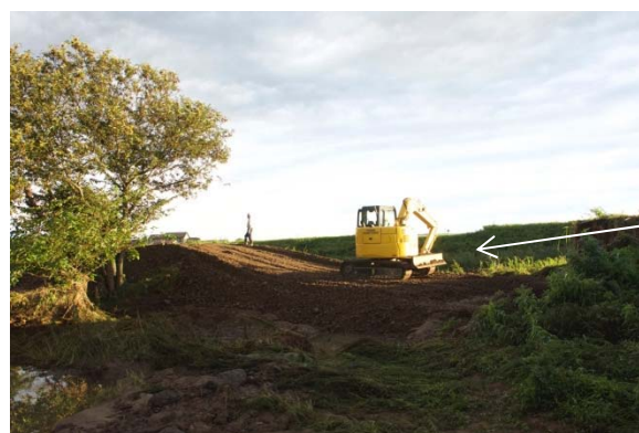
上流工区復旧状況(13日17:00)
