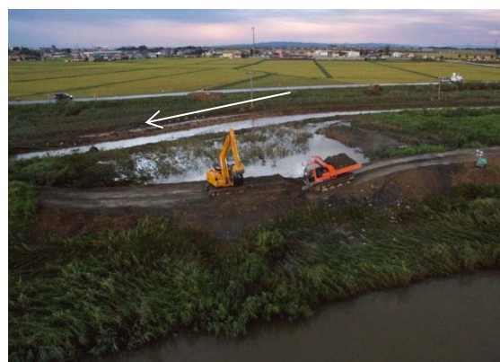
下流工区復旧状況(13日17:00)
