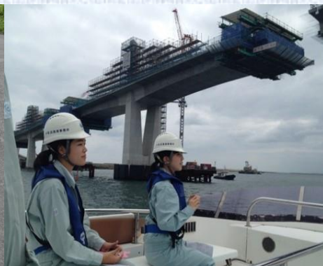
【小名浜港橋梁建設現場】
