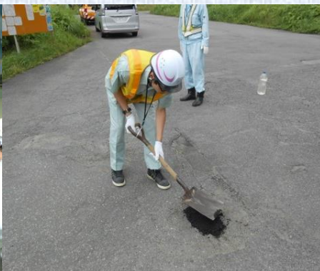
【道路損傷復旧】
