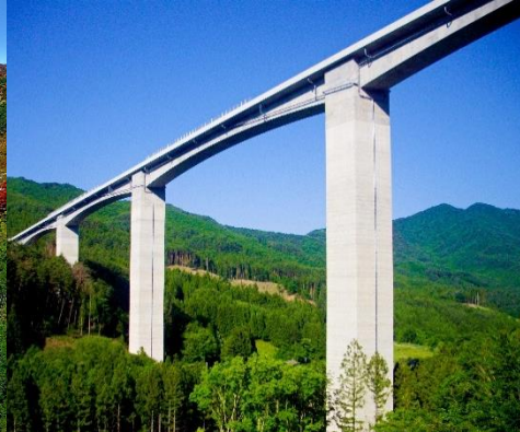
【越喜来高架橋(三陸沿岸道路)】
