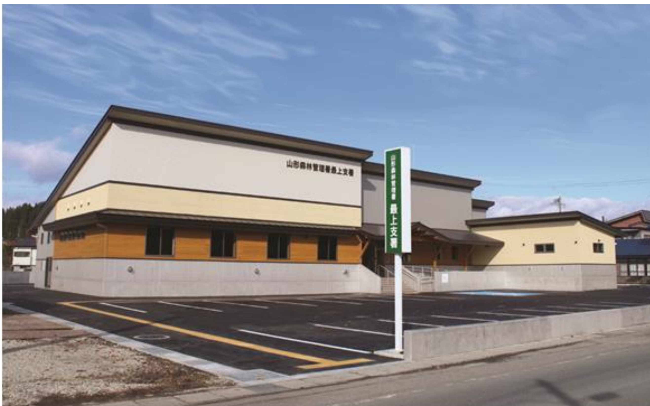
〔前面道路から庁舎南西側を望む〕
