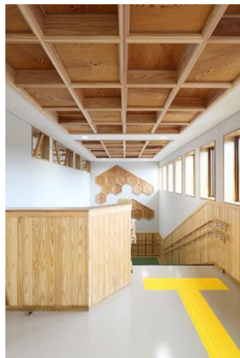
〔旧庁舎から移設した天然秋田杉の格子天井及び壁面レリーフ〕
