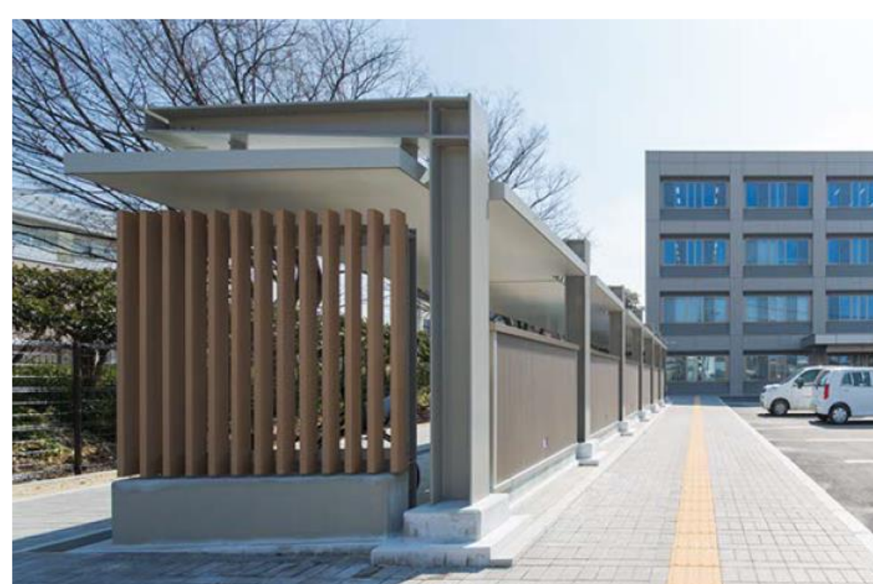
〔融雪対応のアプローチ歩道と木材活用を図った自転車置場〕
