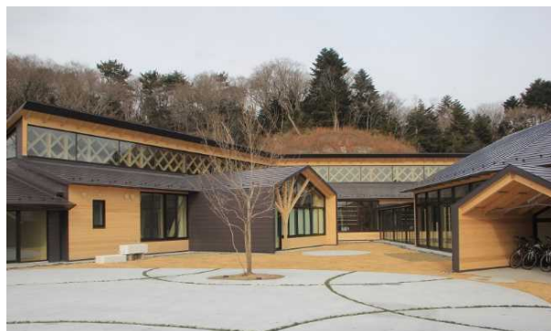
〔東松島市立宮野森小学校の外観〕
