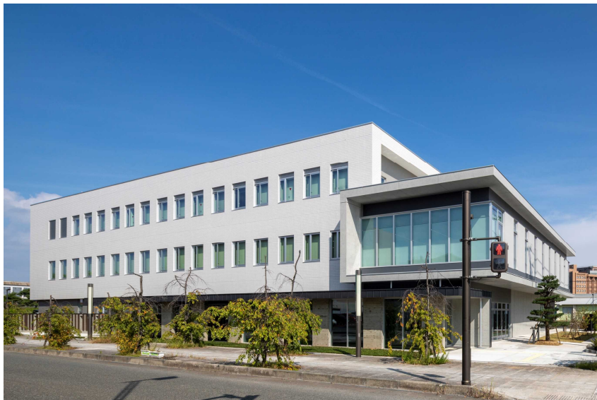
[庁舎南側外観]
