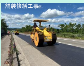
舗装修繕工事
