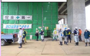
橋梁補修工事の点検
