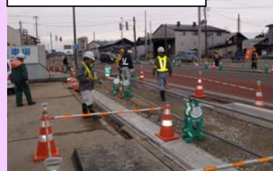
歩道補修工事の点検
