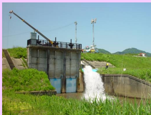
排水作業中の様子
