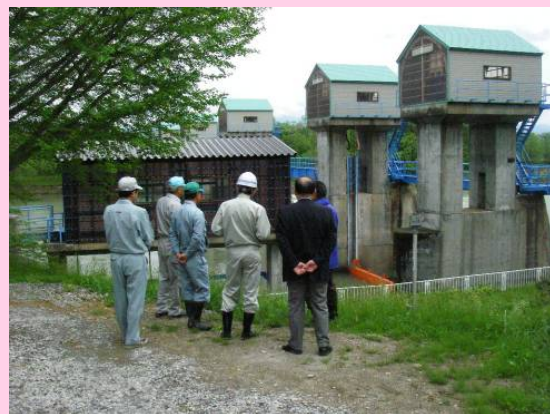
松倉頭首工の点検の様子
