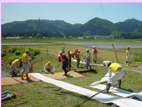
排水ホース設置状況の様子
