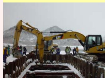
現場パトロールの様子
